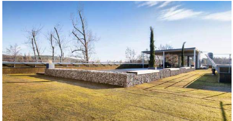
Moosmatten begrünen die Dachterrasse und reinigen die Luft
