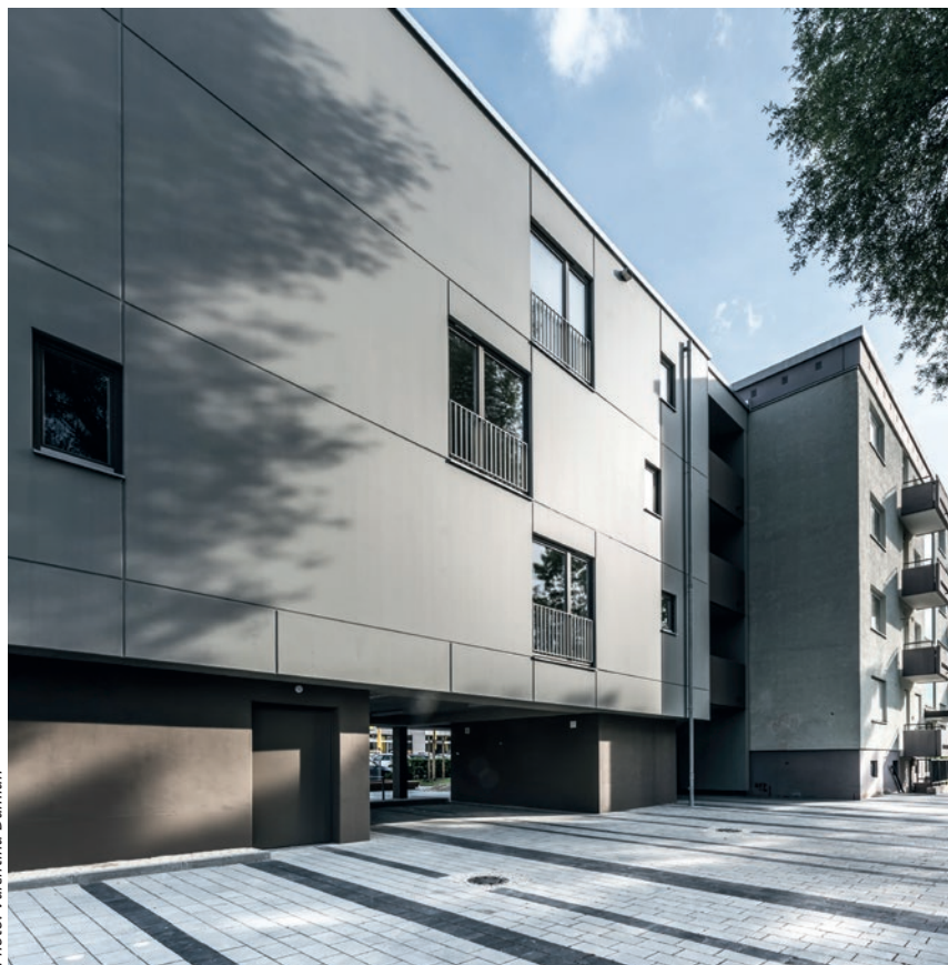
Geschosswohnungsbau in Freising: Anbau mit Thermowänden in Sichtbetonoptik und mit beige-grauer Lasur im Sockelgeschoss.
